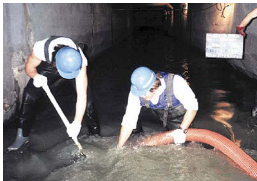
下水道管の清掃
