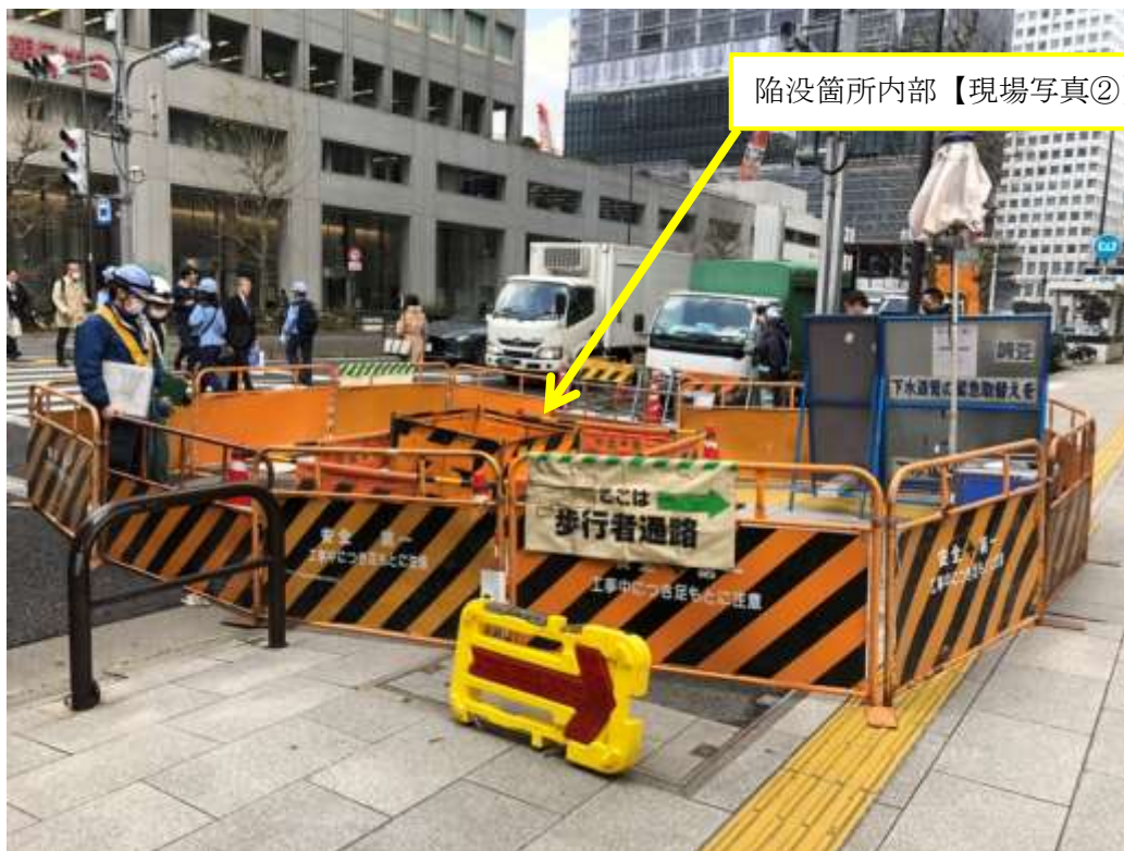
現場写真①（令和2年2月17日撮影）
