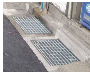
グレーチング蓋への取替え
