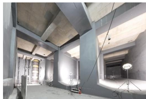
雨水貯留施設の内部
