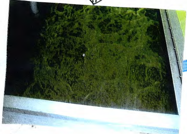
この中で生物が水にとけた汚れを分解します。
