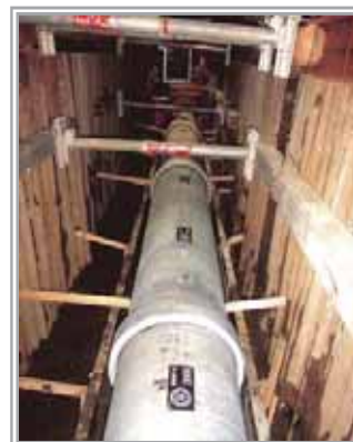
（管きよの布設替え状況）
