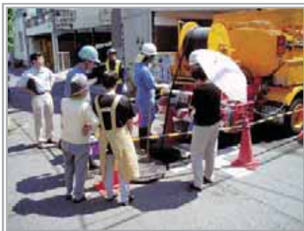
（管きよの清掃作業）
