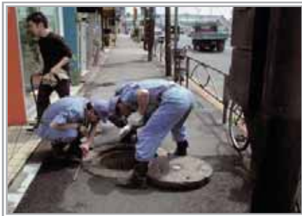
（管きよの点検作業）
