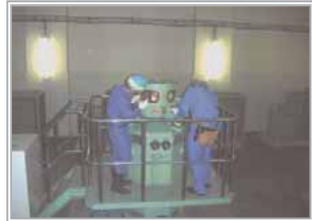
（ポンプ所の点検作業）
