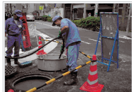
（飛散防止型人孔蓋の清掃作業）
