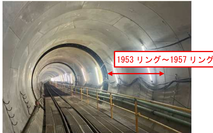
図 2-1 切削セグメント箇所の坑内写真
