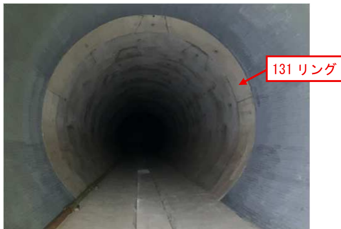
図 2-4 切削セグメント箇所の坑内写真
