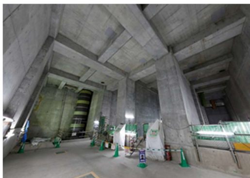
図表 5-8 渋谷駅東口地下に整備された雨水貯留施設
