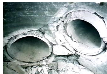
下水道管の突出し(①阪神・淡路大震災)
