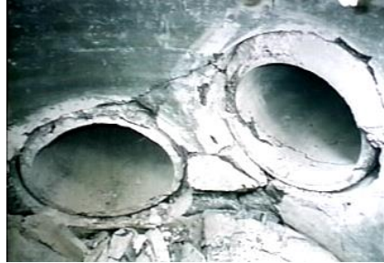
阪神・淡路大震災発生時の 下水道管の突き出し状況
