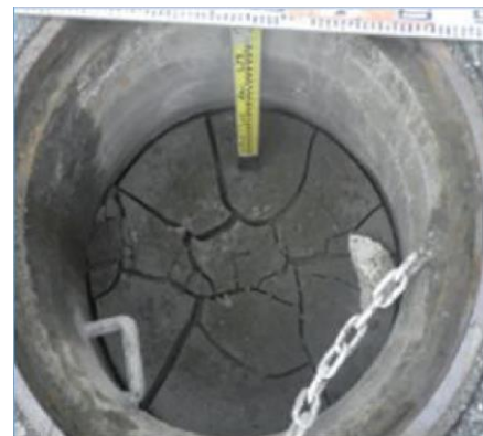
マンホール内への土砂流入状況 (④東日本大震災)
