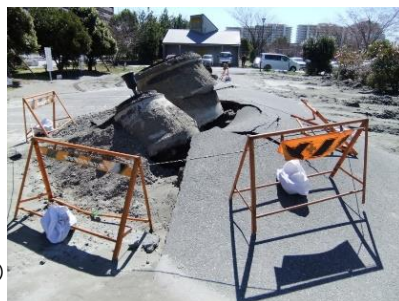
▶マンホール浮上被害事例 （東日本大震災時：2011年）
