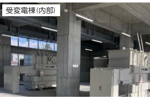
▲立川市単独処理区の流域下水道の編入に向け、受変電設備の再構築を実施（北多摩二号水再生センター） ▶関連 38ページ
