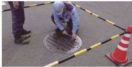
<マンホール蓋点検の様子>
