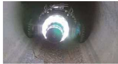
<管路内調査の様子>
