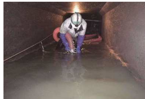
<管路内清掃の様子>
