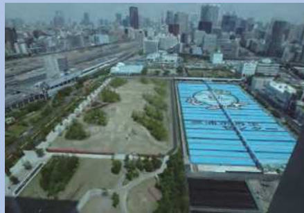
水処理施設を覆蓋して上部を公園として利用 (写真左側)
