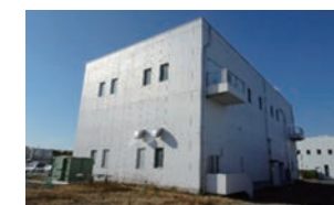
単独処理区編入のためのポンプ棟の整備 (北多摩二号水再生センター)
