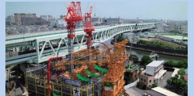
王子第二ポンプ所
