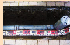
<破損した取付管を衝撃に強い硬質塩化ビニル製の取付管へ取替え>
