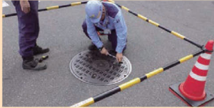
<マンホール蓋点検の様子>
