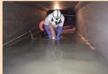
<管路内清掃の様子>
