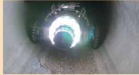
<管路内調査の様子>
