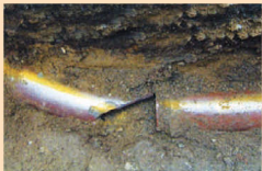
<破損した取付管を衝撃に強い硬質塩化ビニル製の取付管へ取替え>
