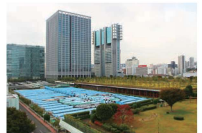
▲芝浦水再生センター内に「品川シーズンテラス」がグランドオープン(平成27年)
