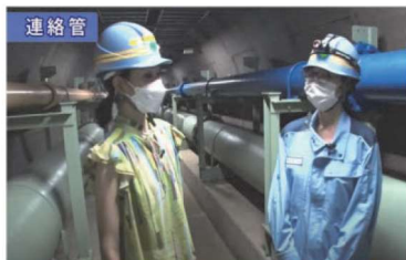
2つの水再生センターを結ぶ連絡管について職員が解説
