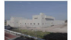
単独処理区編入のための水処理施設の整備 (八王子水再生センター)
