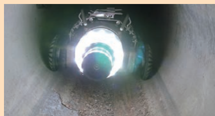
＜管路内調査の様子＞
