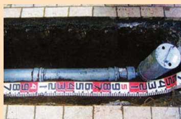
＜破損した取付管を衝撃に強い硬質塩化ビニル製の取付管へ取替え＞
