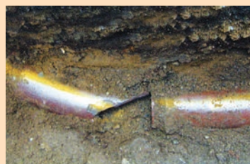
＜破損した取付管を衝撃に強い硬質塩化ビニル製の取付管へ取替え＞
