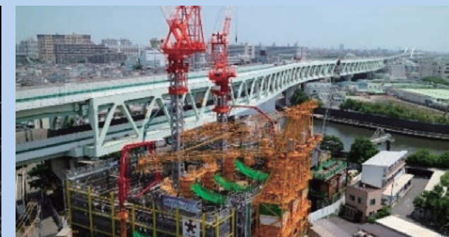
王子第二ポンプ所
