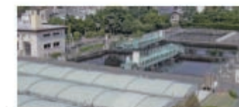
立川市錦町下水処理場(昭和42年稼働)
