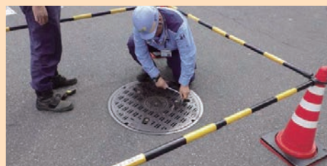
＜マンホール蓋点検の様子＞
