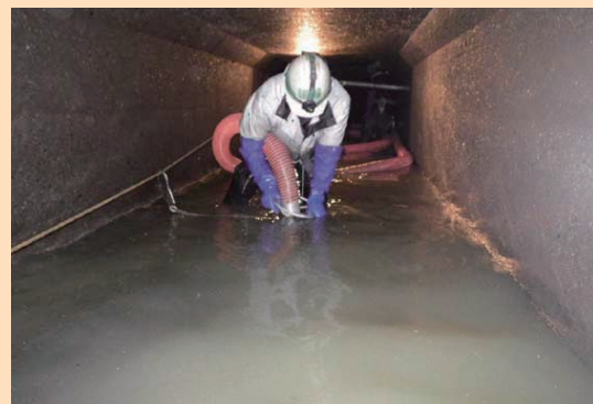
＜管路内清掃の様子＞
