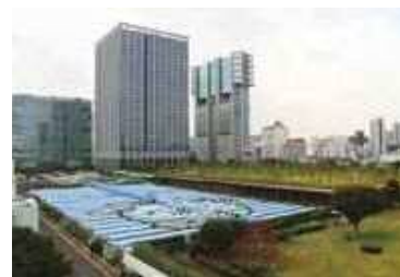
▲芝浦水再生センター内に「品川シーズンテラス」がグランドオープン(平成27年)
