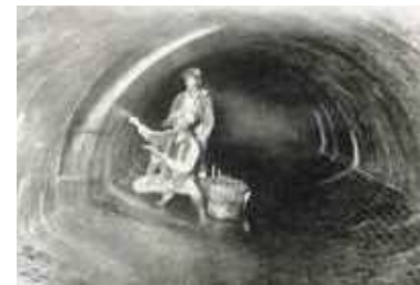
▲大正時代の浅草公園裏下水道管マンホール工事
