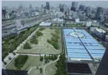
水処理施設を覆蓋して上部を公園として利用 (写真左側)
