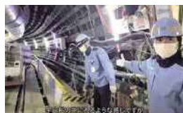
千代田幹線工事現場からのリポーター中継
