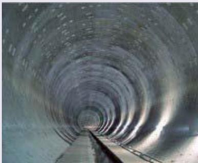
◀ 雨水を貯留する下水道管
