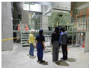
下水道施設の見学（ポンプ所）
