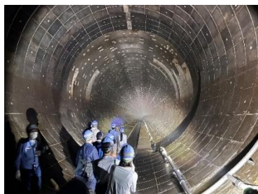
下水道施設の見学（雨水貯留施設）
