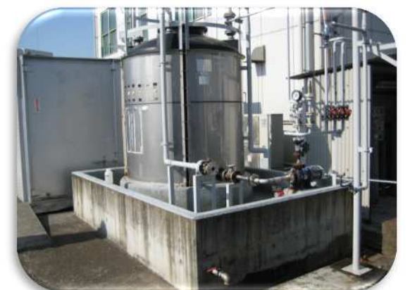
薬品タンクに防液堤を設置
