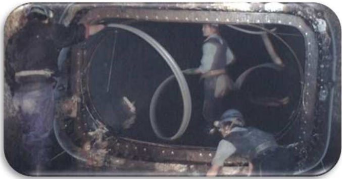
下水道管内の作業
