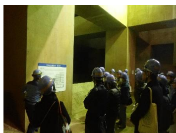
<南砂雨水調整池>
