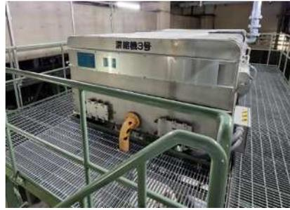
▲省エネルギー型のベルト型汚泥濃縮機 (南多摩水再生センター)
