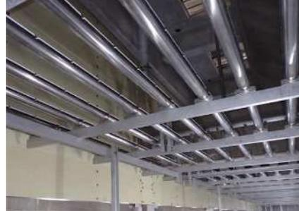
▲高密度配置型散気装置 (北多摩二号水再生センター)
