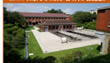
旧三河島污水処分場唧筒場施設
