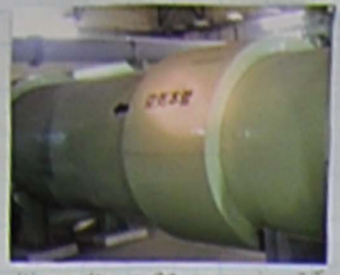
微生物の間に空気を送りこむ装置です。そのための空気を送る300の本管があります。
