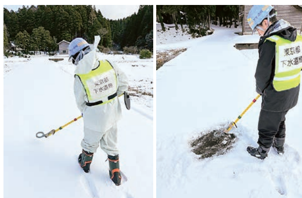
写真-4 金属探知機を使用したマンホール箇所の確認
