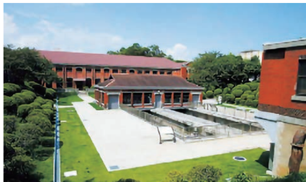
写真-1 旧三河島汚水処分場唧筒場施設
