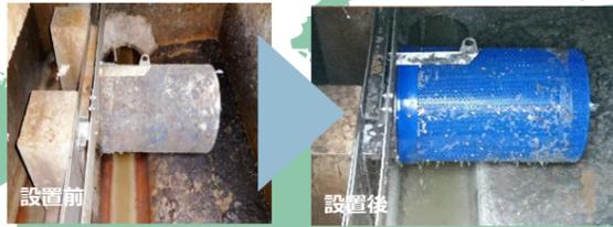
【水面制御装置設置前後のスクリーンの状況】
