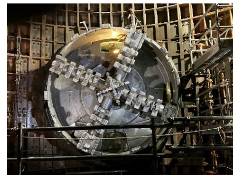
シールドマシン到達の様子 (空堀川上流雨水幹線)
