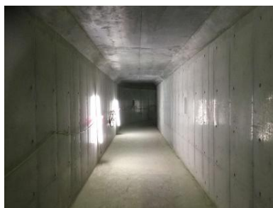
耐震化した放流きょ (八王子水再生センター)
