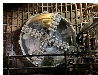
▲シールドマシン到達の様子 (空堀川上流雨水幹線)
