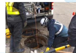
▲テレビカメラを使用した詳細調査
