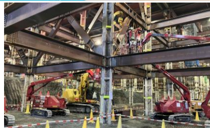
▲水処理施設の老朽化対策とあわせて耐震性の向上を図る再構築(芝浦水再生センター)
