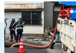
▲下水道管内の清掃作業
