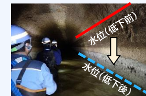
水位低下を図った上での調査
