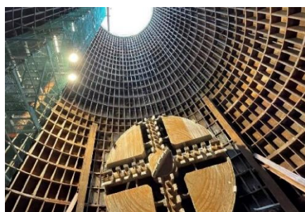
▲ シールドマシン到達状況(千川増強幹線)
