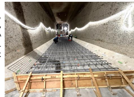
▲耐震補強の施工の様子 (神谷ポンプ所)
