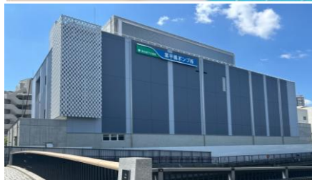
▲ポンプ棟の本体が完成した業平橋ポンプ所
