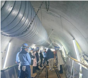
▲インフラツアー(呑川増強幹線工事現場)
