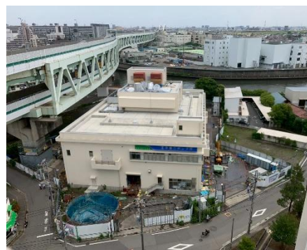
▲2026年3月に完成した王子第二ポンプ所
