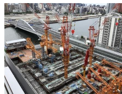
▲ ポンプ所の施工状況(勝どきポンプ所)
