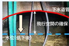
水位を低下させドローンの飛行空間を確保（管径2.7m 通常時は満水）
