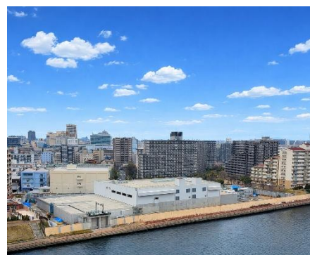
▲2026年3月に完成した千住関屋ポンプ所
