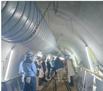
▲インフラツアー(呑川増強幹線工事現場)
