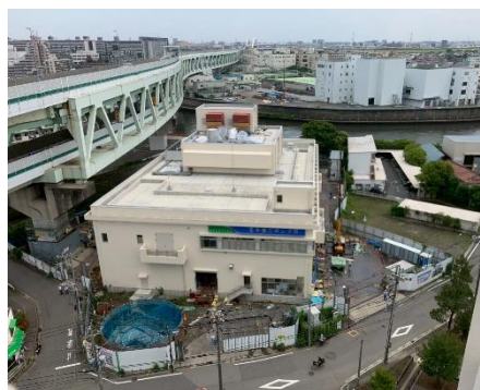
▲2026年3月に完成した王子第二ポンプ所
