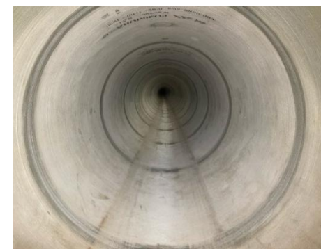
▲工事中の貯留施設 (石神井川流域貯留管) (3,600m³)
