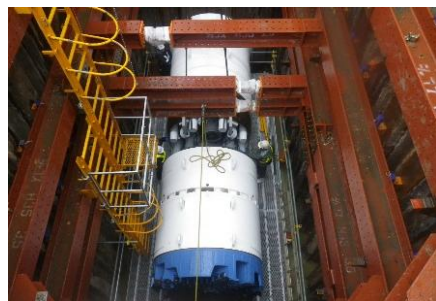
▲ シールドマシン設置状況(北区滝野川地区主要枝線)
