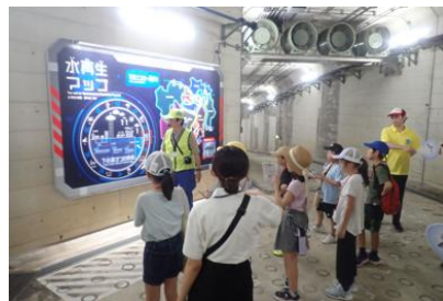
▲こども下水道アドベンチャーツアー (有明水再生センターを見学)
