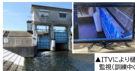
▲樋門操作訓練(八王子水再生センター)の様子
