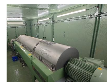
▲再構築を行った脱水設備 (北多摩一号水再生センター)
