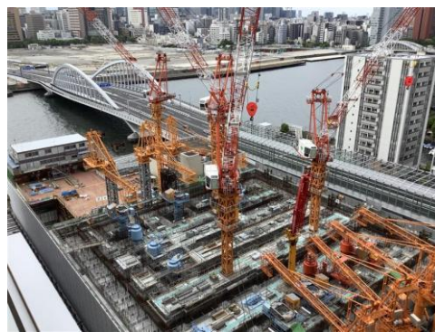
▲工事中の勝どきポンプ所 (千代田区永田町、中央区勝どき地区)
