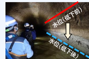
水位低下を図った上での調査
