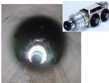
▲人の入れない口径の小さい下水道管におけるテレビカメラを用いた管路内調査
