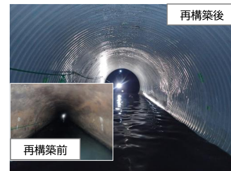
▲再構築を行った木場幹線
