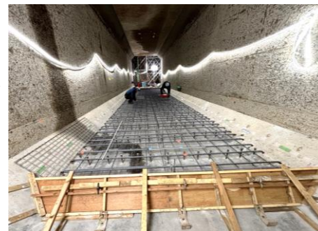
▲耐震補強の施工の様子 (神谷ポンプ所)
