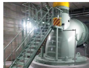
▲再構築を行ったポンプ設備 (小菅水再生センター)
