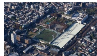
▲ 落合水再生センター
