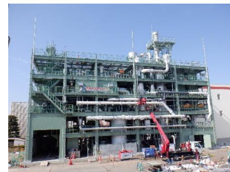
工事中の省エネルギー型汚泥焼却炉 (北多摩一号水再生センター)
