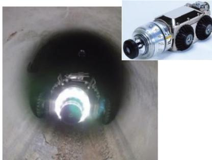
▲人の入れない口径の小さい下水道管におけるテレビカメラを用いた管路内調査
