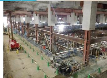
▲老朽化対策とあわせて雨水排除能力の増強や耐震性の向上などを図る再構築
