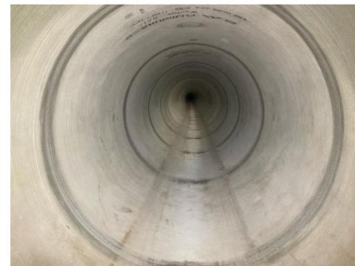
▲工事中の貯留施設 (石神井川流域貯留管) (3,600m<sup>3</sup>)
