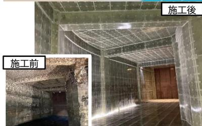
▲コンクリートの腐食対策や補修、大規模改築などにより、施設の機能を維持(防食工法の例)
