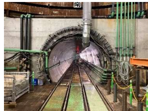
地下約20mを工事中的空堀川上流雨水幹線
