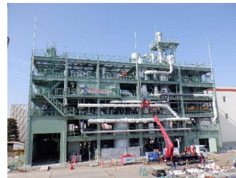
工事中の省エネルギー型污泥焼却炉 (北多摩一号水再生センター)
