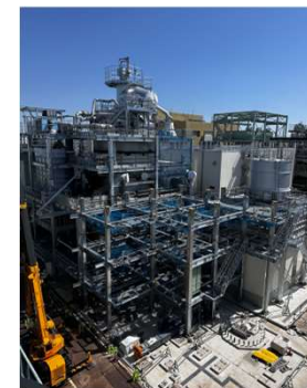
工事中のエネルギー自立型焼却炉 (南部スラッジプラント)
