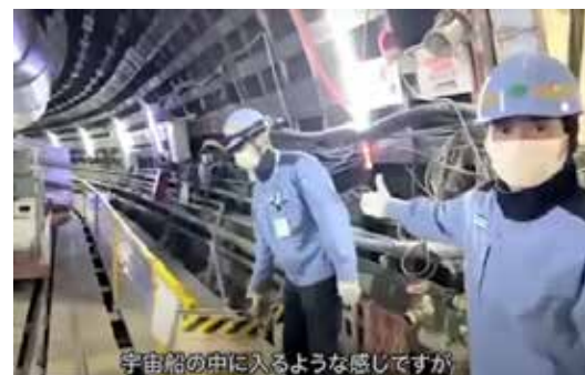
下水道インフラオンライン見学会 千代田幹線工事現場からのリポーター中継
