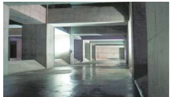
南砂雨水調整池
