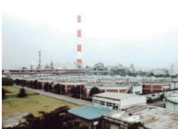
汚泥消化槽が並んだ様子（砂町処理場）
