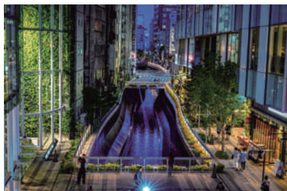
壁泉への再生水の活用（渋谷川）
