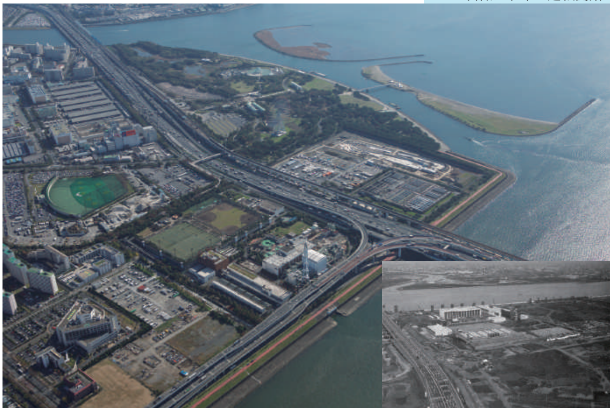
現在 (2018年) と稼働当初 (1981年) の葛西水再生センター
