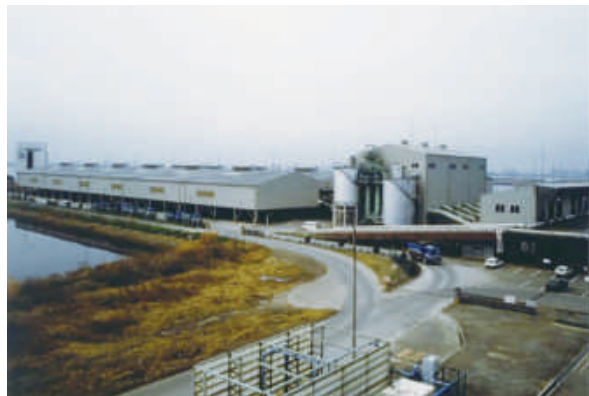
中防ミキシングプラント （中央防波堤内側埋立地）
