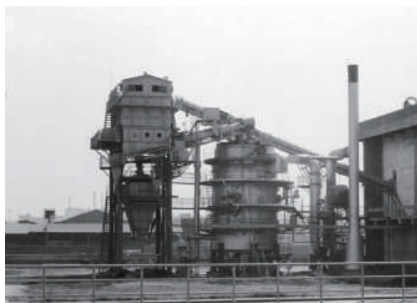
汚泥焼却炉（小台処理場）
