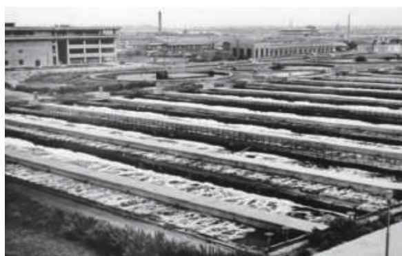
ステップエアレーション法の 曝気槽（1960年頃）
