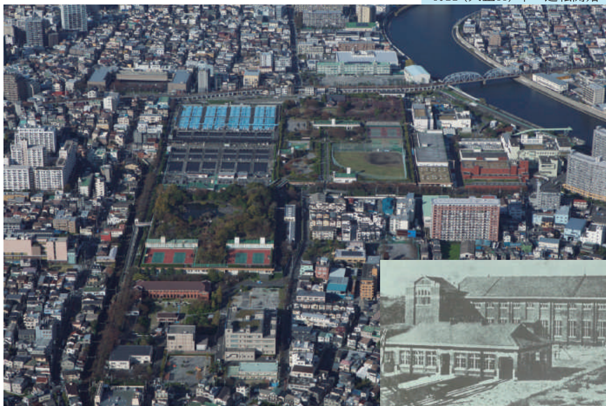
現在 (2018年) と稼働当初 (1922年) の三河島水再生センター
