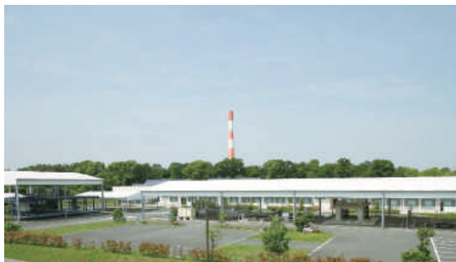
下水道技術実習センター
