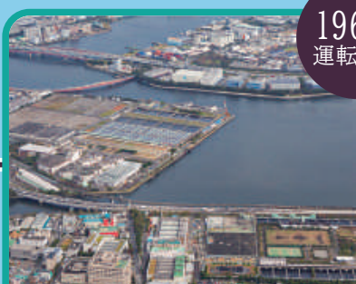
森ヶ崎水再生センター
