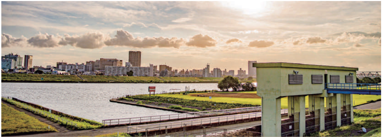
小菅水再生センター放流渠（平成30年）
