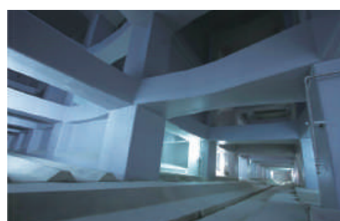
雨天時貯留池（76,000m 3 ）
