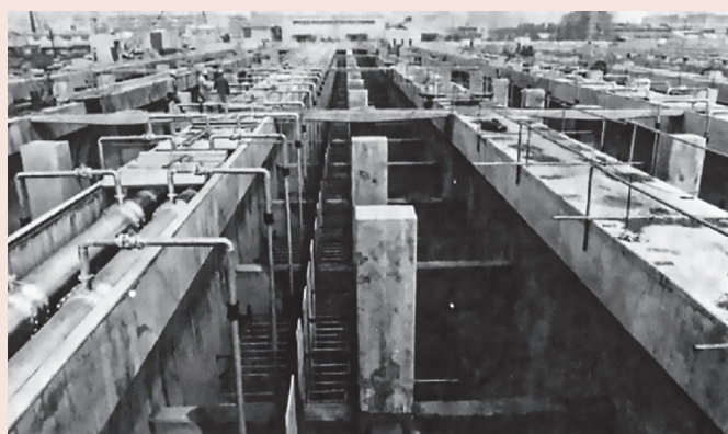
深槽反応槽（1975年-）
