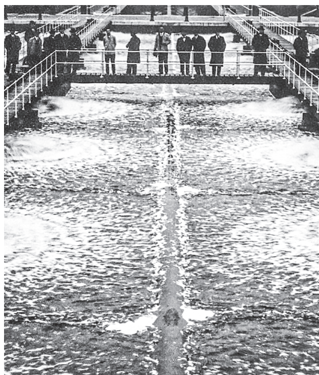
芝浦污水処分場シンプレックス式曝気槽（昭和13年）
