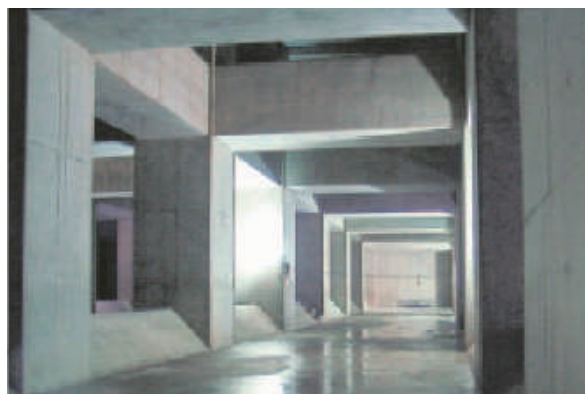
南砂雨水調整池
