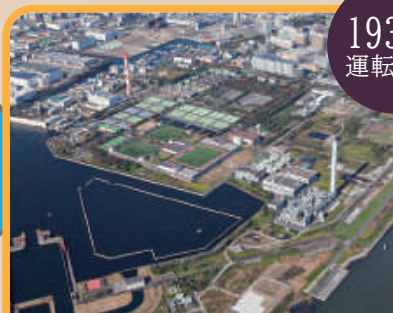
砂町水再生センター
