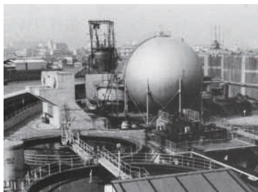
汚泥処理工場のガスタンク（1980年頃）
