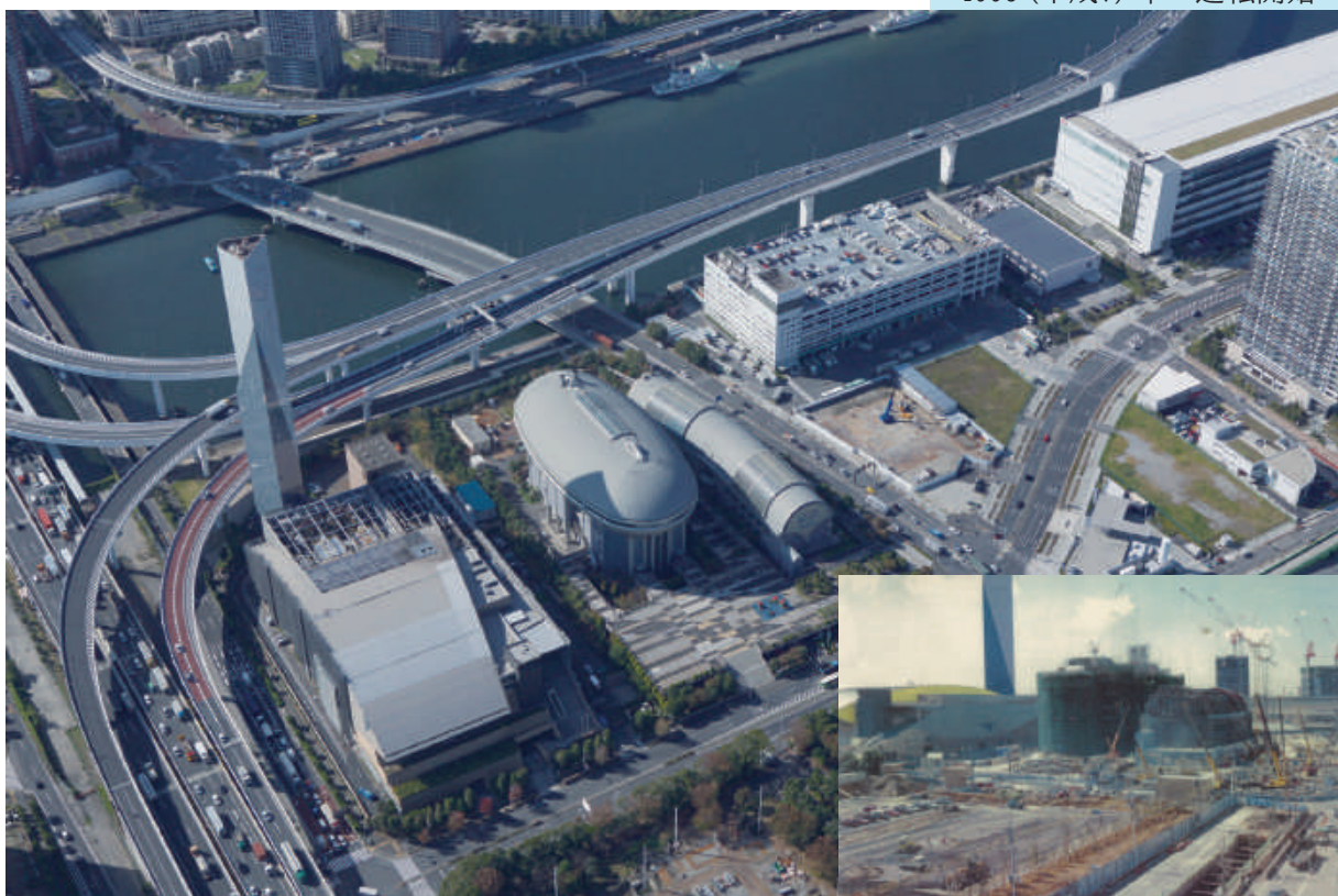
現在 (2018年) と建設工事中 (1994年) の有明水再生センター
