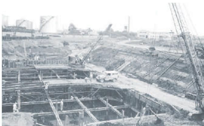
浮間処理場の建設
