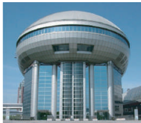
江東区有明スポーツセンター
