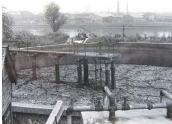
滓渣槽（三河島污水処分場）
