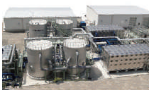
セラミック膜ろ過による再生水製造施設
