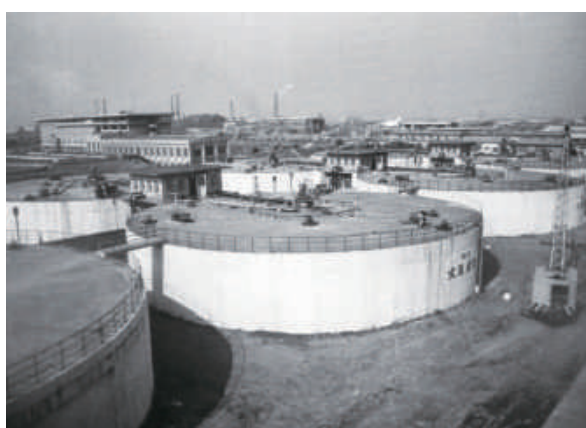
2重式(低温)消化槽(砂町処理場)
