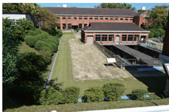
旧三河島污水処分場 ポンプ 唧筒場施設
