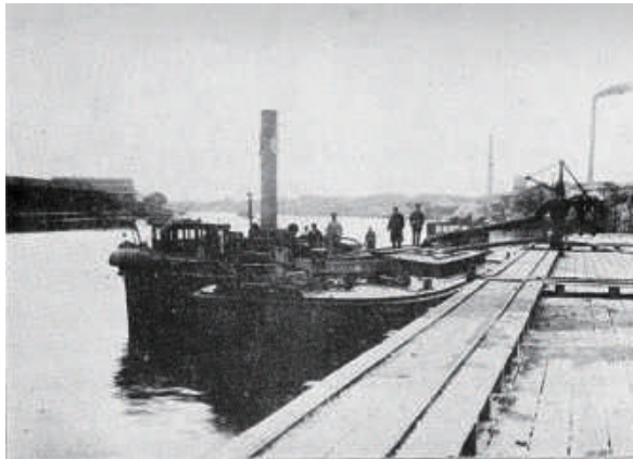
汚泥運搬船（三河島污水処分場）
