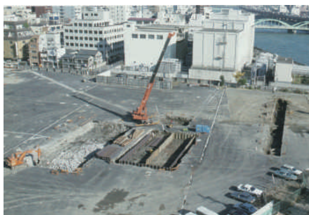
蔵前ポンプ所建設着手（1986年）
