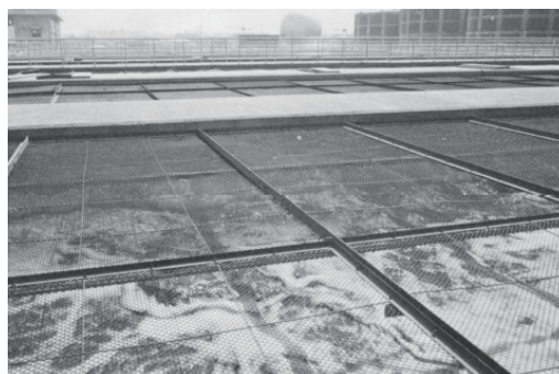
曝気槽（現在の反応槽） （西処理施設・1965年）
