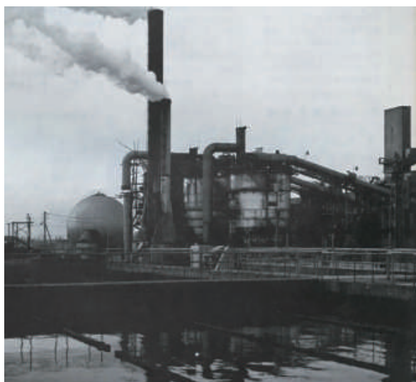
多段焼却炉（砂町処理場）
