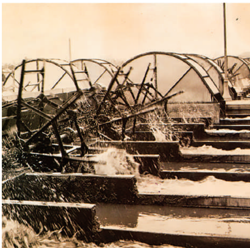
三河島污水処分場パドル式曝気槽（昭和9年）
