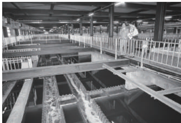
鉄筋コンクリートで覆蓋された沈殿池
