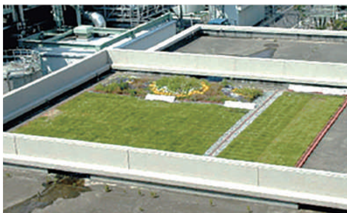
屋上緑化材として活用（南部スラッジプラント）
