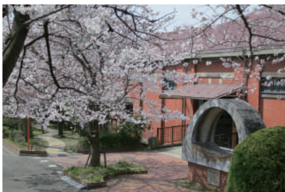
三河島汚水処分場 ポンプ 唧筒場施設と馬蹄型下水渠
