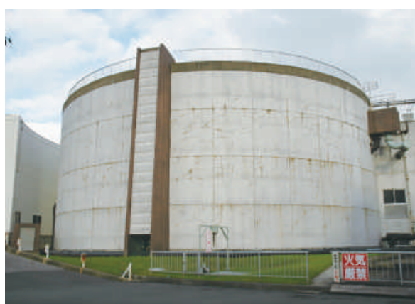
2段式(高温)消化槽(森ヶ崎水再生センター)
