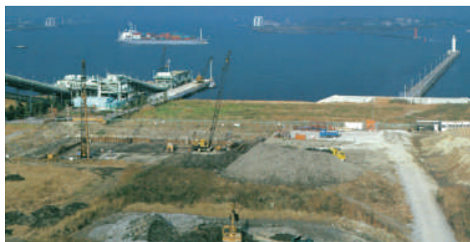
南部スラッジプラント汚泥燃料化施設建設工事
