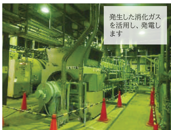
消化ガス発電（消化槽・発電機）
