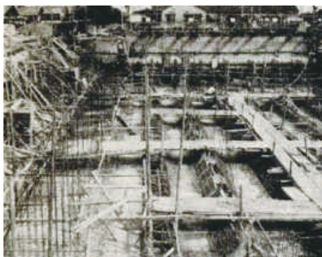
芝浦処理場の建設（1957年）
