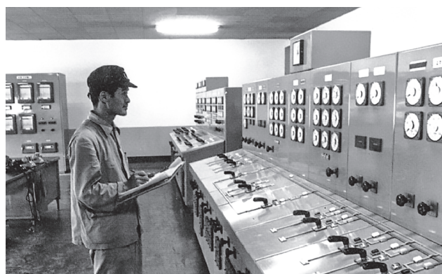
小台処理場中央管理室（昭和39年）
