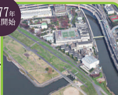
小菅水再生センター
