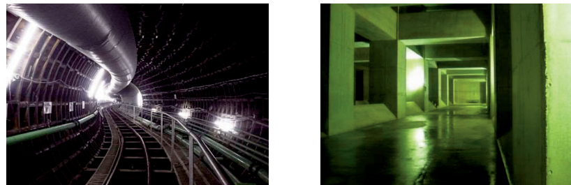
図表 6-1 浸水対策幹線の整備例（千川増強幹線）（左）、 雨水貯留施設の整備例（南砂雨水調整池）（右）
