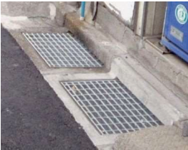
グレーチング蓋への取替え
