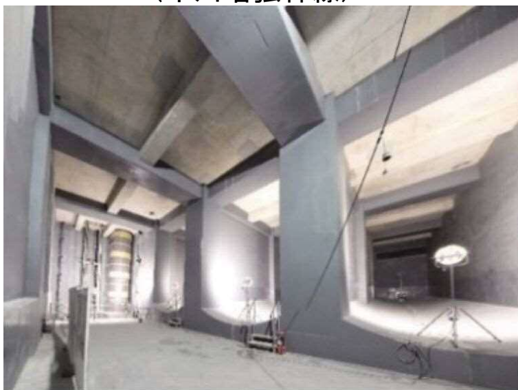
雨水貯留施設の整備例 (渋谷駅東口貯留施設)
