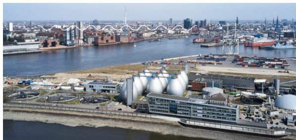
Köhlbrandhöft 下水処理場全景※ 1
