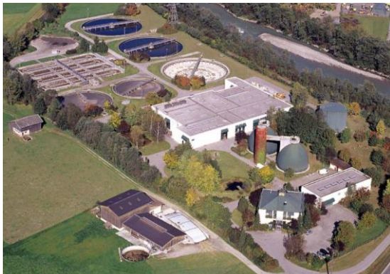
下水処理場全景※1
