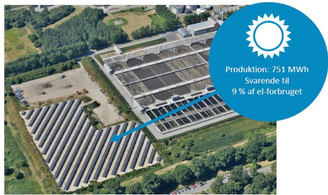
太陽光発電設備 (Damhus å en 処理場) ※2
