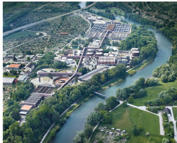
Zürich Werdhözli 下水処理場全景※1
