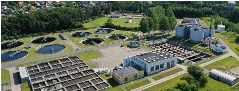
Marselisborg 下水処理場全景※1
