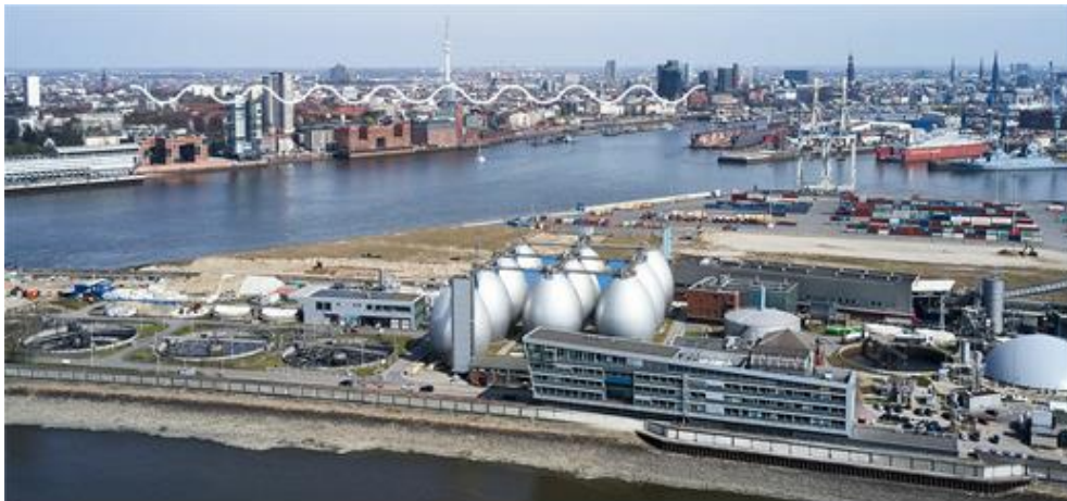
Köhlbrandhöft 下水処理場全景※1
