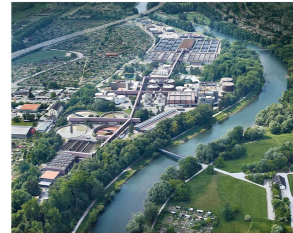
Zürich Werdhölzli 下水処理場全景 ※1
