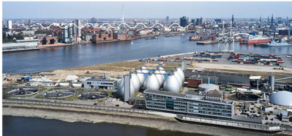
Köhlbrandhöft 下水処理場全景 ※1
