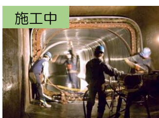
【更生工法を活用した下水道管リニューアルのイメージ】
