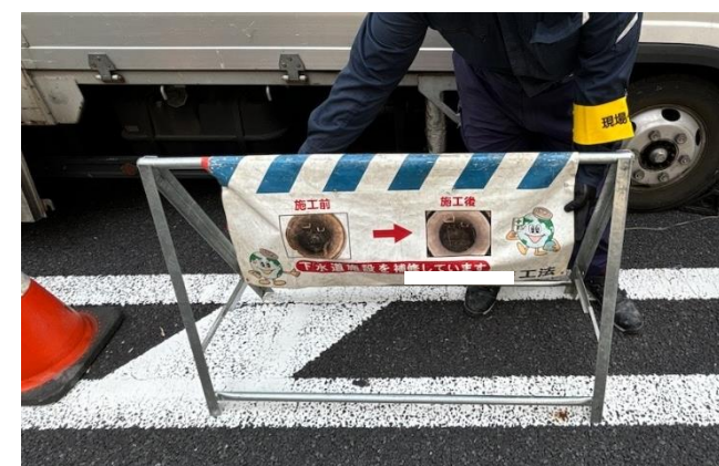
分かりやすい施工前・後の写真
