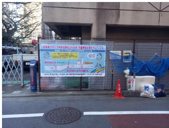
工事現場イメージアップ看板
