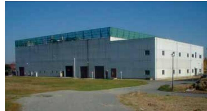
周辺への配慮のため防音壁を築造し、その内側に焼却設備を設置
