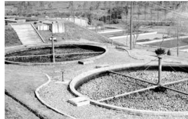
散水ろ床方式による多摩平処理場
