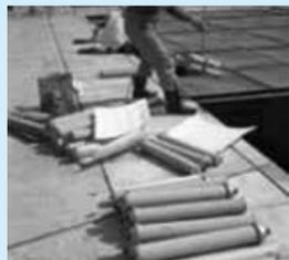
下水に空気を送るための散気筒
