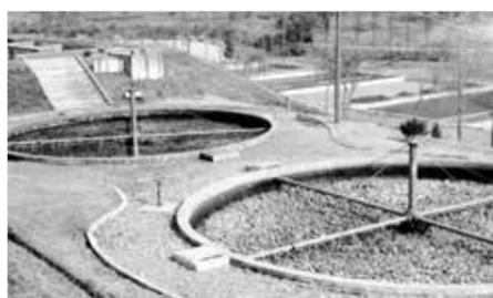
昭和46年に南多摩処理場が稼働したのを皮切りに処理場の建設、下水道の整備が進んだ。処理方法は標準活性汚泥法が主流であった。
