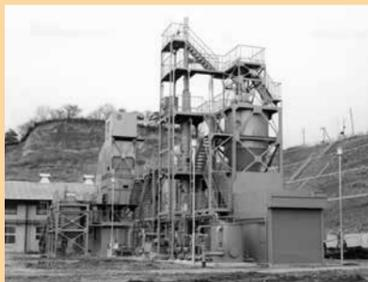
下水道局初となる流動焼却炉、燃焼効率が良く当時は最先端の技術
