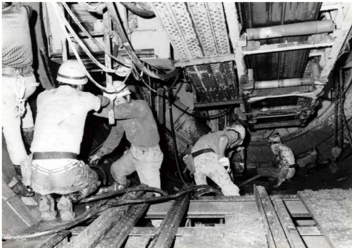
(上)、(下) 野川処理区 野川第一幹線シールド工事 (昭和46年)
