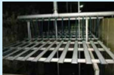
小さな気泡を発生させ下水に酸素を溶けやすくすることで、送風機の電力使用量が削減
