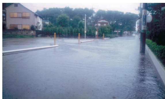
前沢雨水幹線整備前
