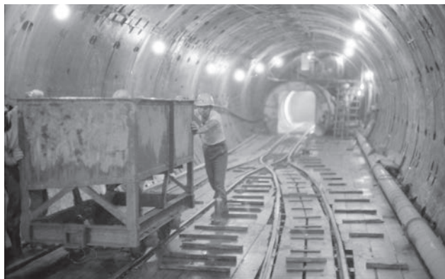
北多摩一号幹線 シールド工事
