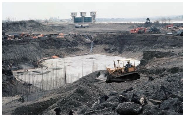
北多摩一号処理場建設中の様子
