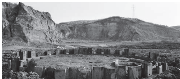
山中の乞田幹線工事現場（深さ36mの立坑） （パイルの内側にはさらに円筒の枠を組んで掘削した）
