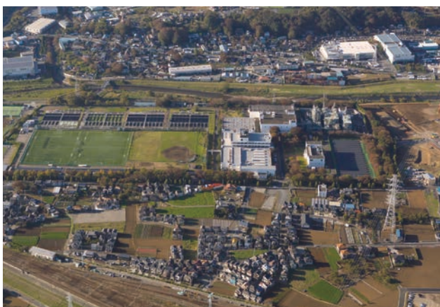
清瀬水再生センター（平成30年）
