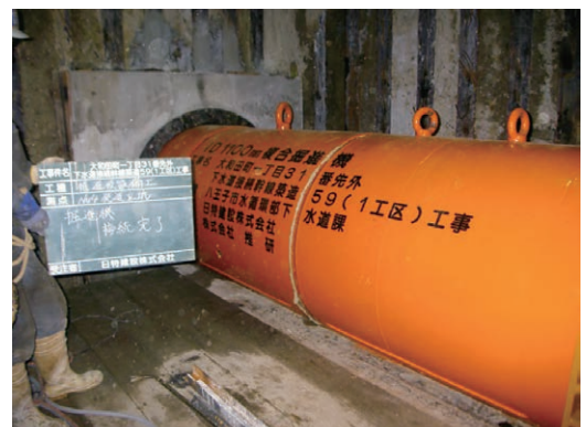
建設中の接続幹線（平成26年）
