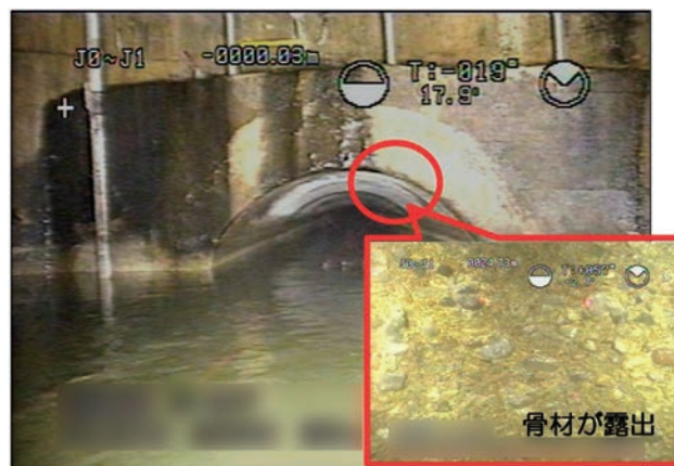
乞田幹線管路内調査状況
