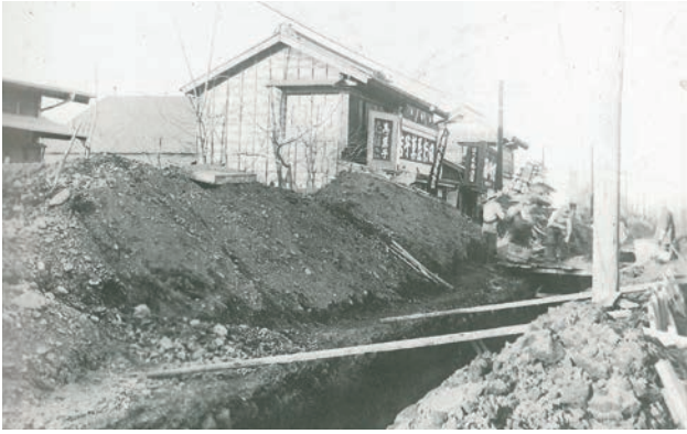
錦中央通りの下水道工事風景（立川市、昭和初期） （提供：立川市歴史民俗資料館）
