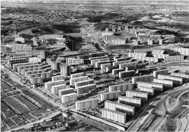
急ピッチで建設の進む多摩ニュータウン (昭和45年12月、提供：朝日新聞社)
