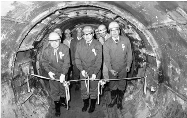
多摩川上流幹線の全線開通
