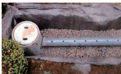
雨水浸透トレンチ
