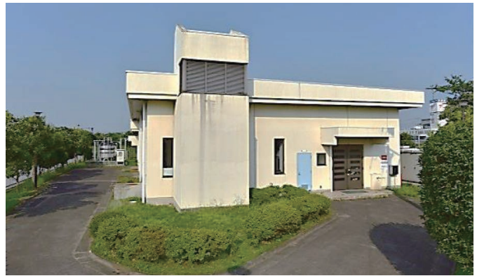
駒形汚水中継ポンプ場
