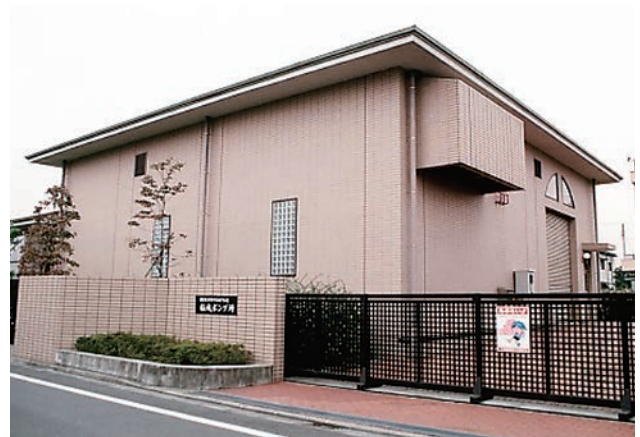
稲城ポンプ所
