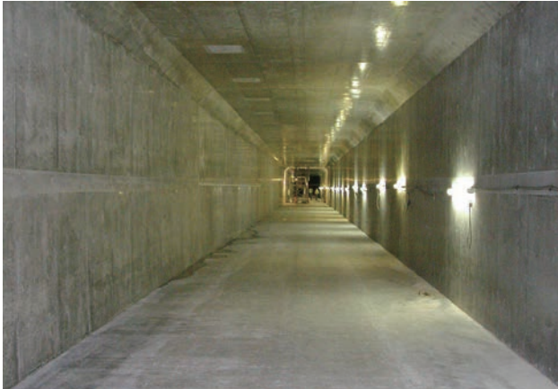
黒目川雨水幹線 完成状況
