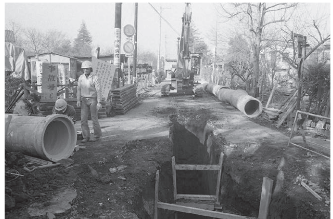
昭和50年下水道管布設工事
