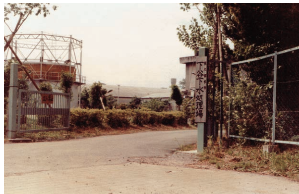
単独公共下水道時代に建設された下谷処理場
