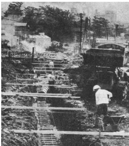
污水管整備が本格化した昭和40年代の工事の様子
