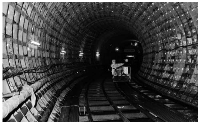
野川第一幹線 一次覆工工事
