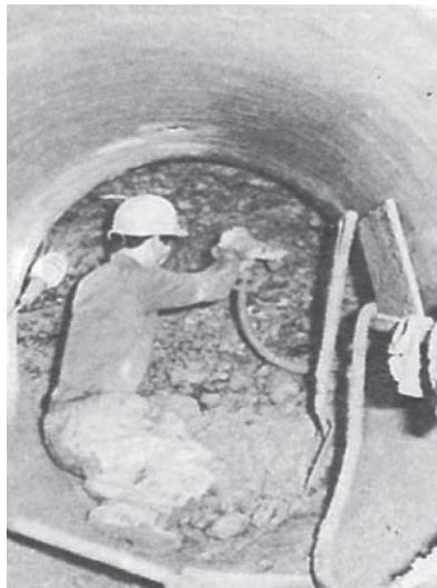
下水道管布設の様子 (昭和53年度市報掲載)
