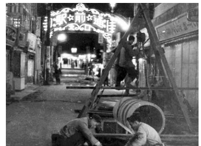
夜間の下水道工事
