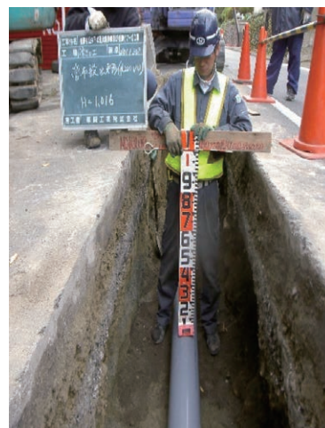
元郷地区施工状況
