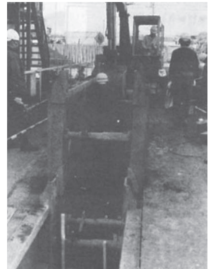
管きよ開削工事の様子 (昭和60年度市報掲載)
