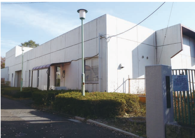
廃止した東町ポンプ場
