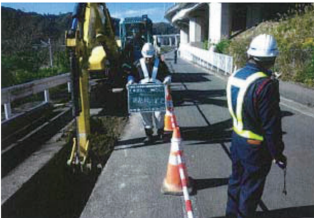
初雁地内污水管枝線工事（平成29年度）
