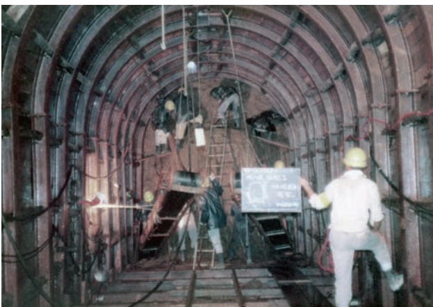
多摩川上流幹線 シールド工事
