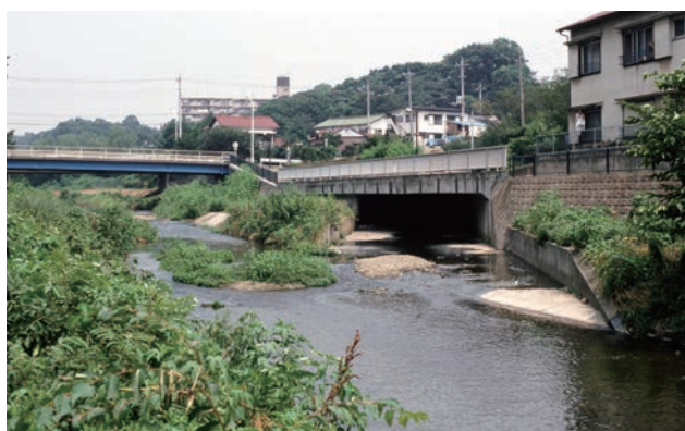
野川第二幹線（雨水吐き）
