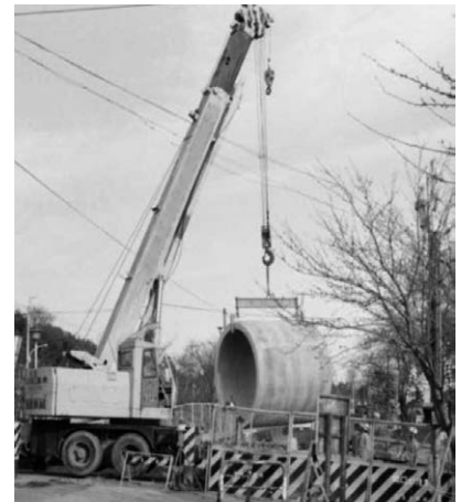
東排水区東一号幹線雨水管布設工事
