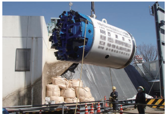
工事に使用したミニシールド機
