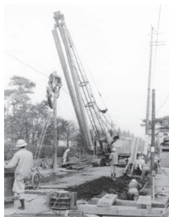
武蔵野市の下水道工事(昭和38年)
