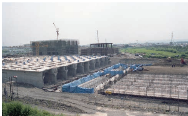
建設中の北多摩二号処理場（第一系列）
