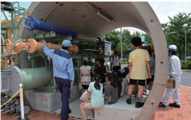
連絡管の目的を分かりやすく伝える「見える化」施設（北多摩一号水再生センター）
