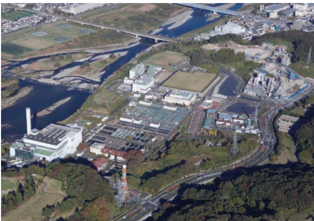
南多摩水再生センター（平成30年）
