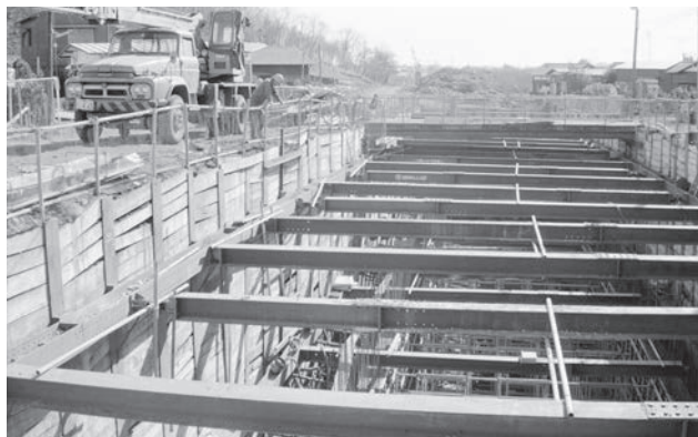
北多摩一号幹線 開削工事
