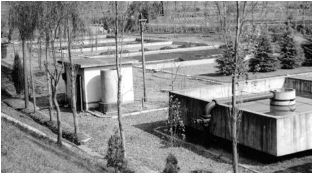
多摩平下水道処理場（日野市、昭和38年）
