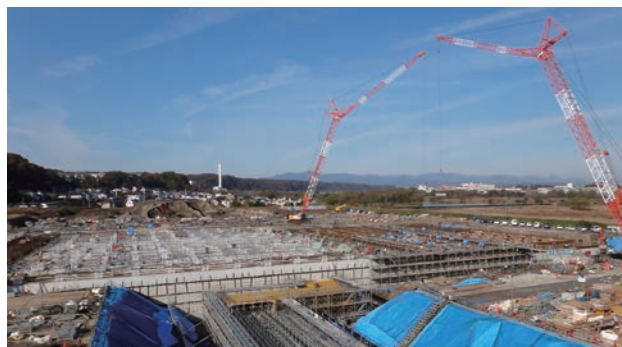
受入れのための工事が進む八王子水再生センター
