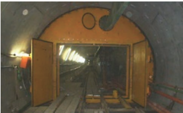
止水壁設置状況
