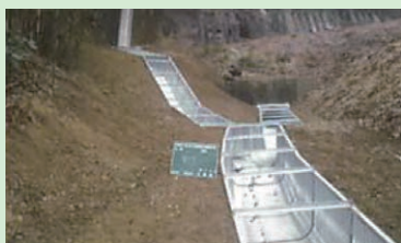
雨水排水路改修
