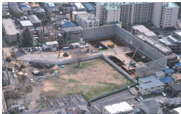
施工中の野川下流部雨水貯留池（平成24年3月）
