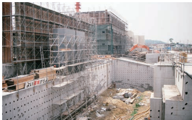
建設中の浅川処理場
