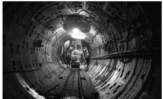
柳瀬幹線 シールド工事
