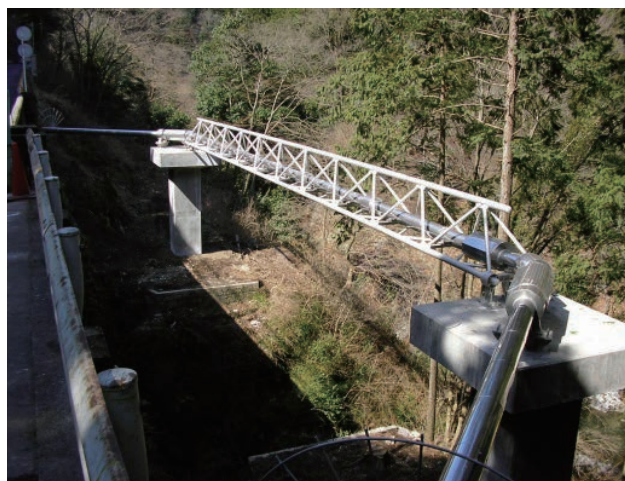
あきる野幹線 水管橋
