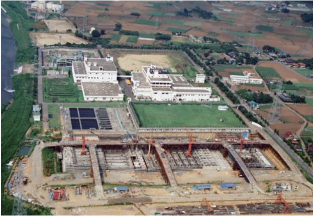
建設中の清瀬処理場（水処理第2系列）
