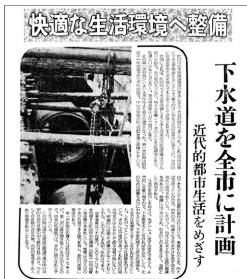
当時の下水道工事の様子 (広報まちだ昭和44年7月20号より)
