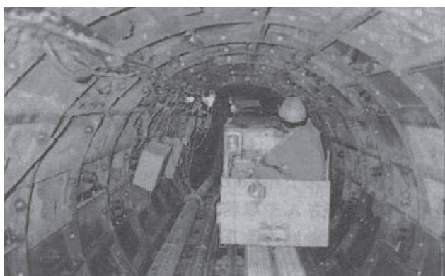
秋川幹線 掘削の様子
