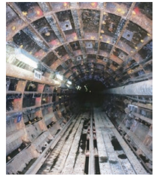
鶴川幹線シールド内部
