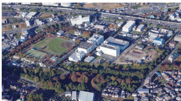
北多摩二号水再生センター（平成30年）
