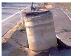
地盤の液状化によるマンホールの浮上
