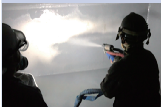
塗布作業状況
