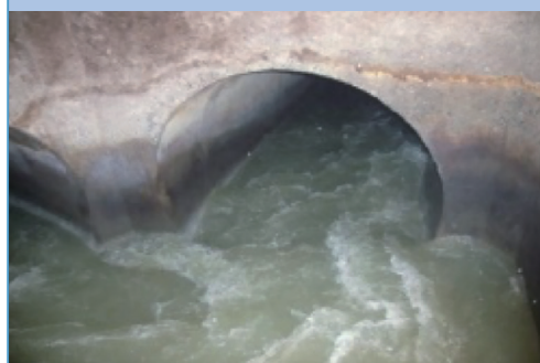
高水位の下水道管
