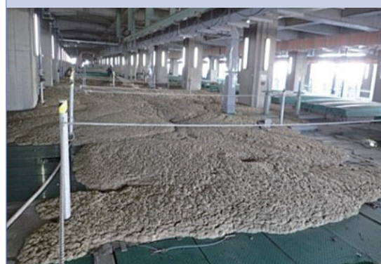
反応槽から流出した放線菌の泡
