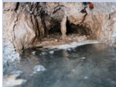
下水道管内の付着状況
